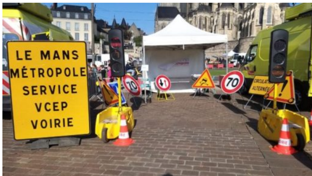
Exposition des panneaux (zone de travaux).
