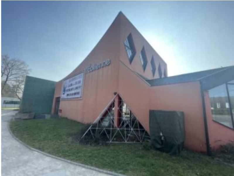
Espace culturel de l'Éolienne.
