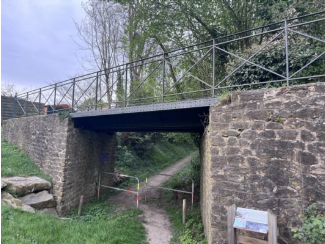
Caption: Le Pont du Tramway
