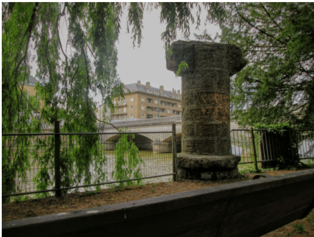
Caption: Pilier du pont en X, vestige 2025
